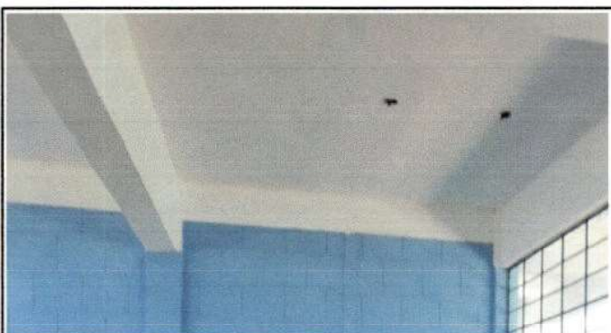
Foto 3: Sustitución de pinturas en muros interiores Módulo I.
