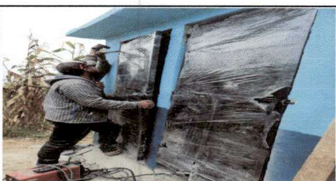
Foto 6: Proceso de sustitución de las puerta de los baños a puertas de metal.
