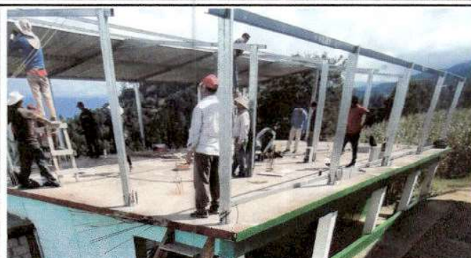
Foto 2: Colocación de la lamina del techo donde se filtraba agua por el mal estado de la lamina.
