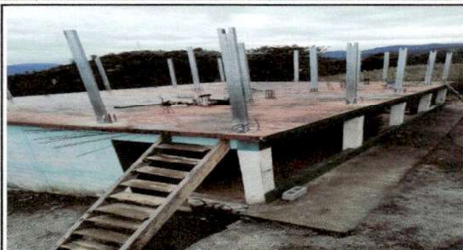
Foto1: En proceso de sustitución del techo debido a que la lamina y la madera estaba en mal estado.
